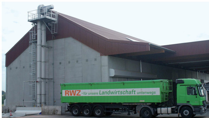
Abb. 1: Über diesen Elevator wird der Dünger in die neue Lagerhalle der RWS befördert.
