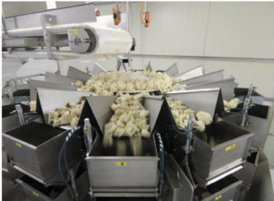
Edelstahl-Know-how aus Lutten: Auch diese Unterverteilung für das Absacken von Blumenkohl stammt vom Fördertechnik-Spezialisten Apullma.
