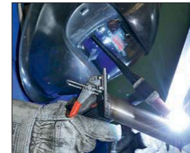
Perfekte Schweißnähte und ein sauberes, klar strukturiertes Gesamtbild lassen die kundenindividuellen Lösungen von Apullma wie ein Serienprodukt wirken.
