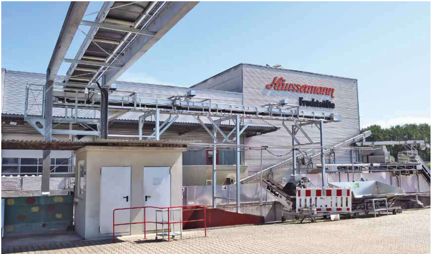
Die neue Förderanlage von Apullma automatisiert die Annahme, Entlaubung und Sortierung von Streuobst
